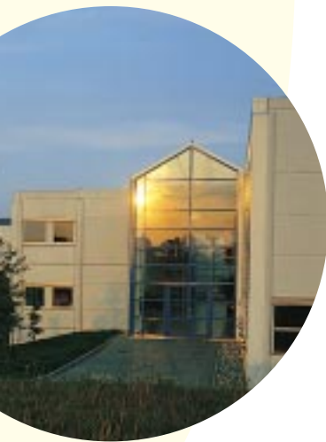
Coloplasts bygninger er bygget og indrettet, så de udgør mindst mulig brandrisiko.
